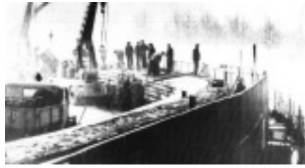
Ostberliner Bauarbeiter errichten die Berliner Mauer. Quelle: Wikimedia / National Archives; Public Domain.
